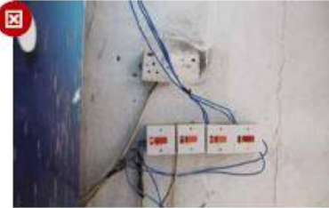
شكل رقم ٦: الأسلاك والأنابيب الخارجية المكشوفة
